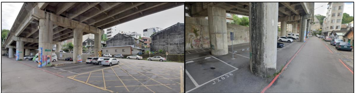
介壽橋下既有巷弄及停車空間
