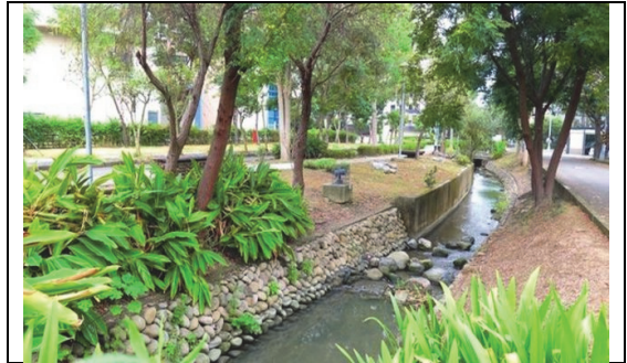
多孔隙護岸設施-卵石駁坎
