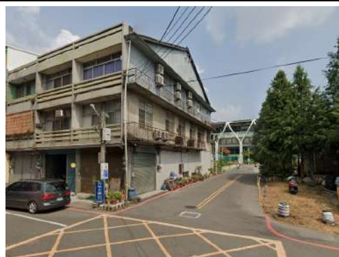
車站後站道路（由員林市公所租用土地，開闢寬度不足計畫路寬）
