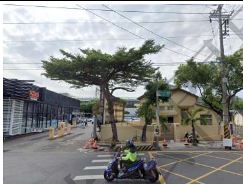
11M-14 道路（鐵路高架下之部分）
